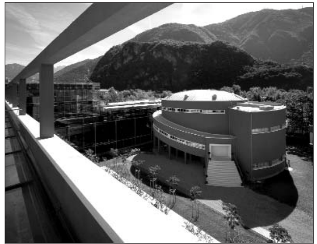
Blick auf das schneckenhausförmige Auditorium der Europäischen Akademie Bozen (EURAC)
